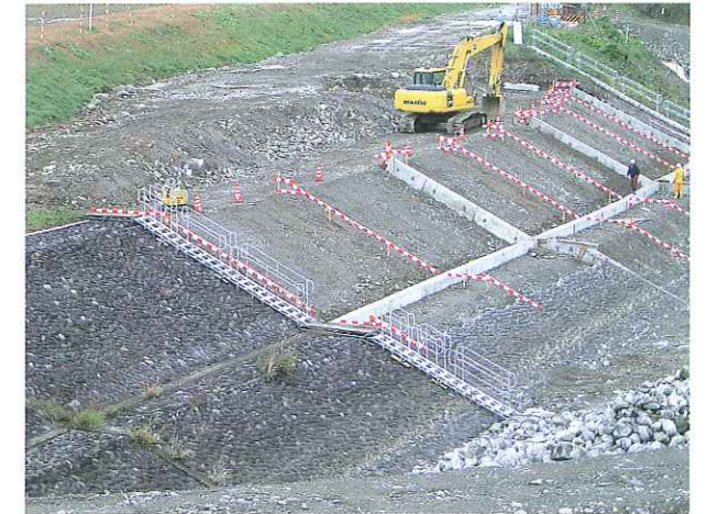
河川護岸工事用の昇降設備
