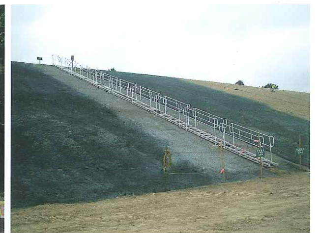
河川護岸工事用の昇降設備
