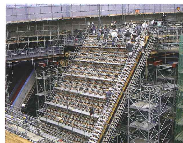
跨道橋架設の昇降設備
