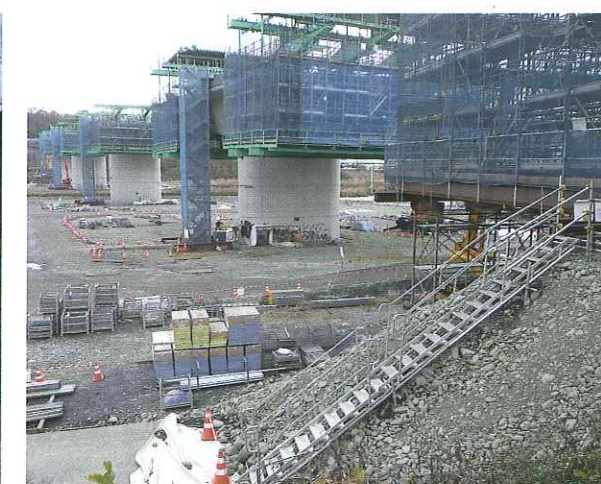
上部工工事の昇降用通路
