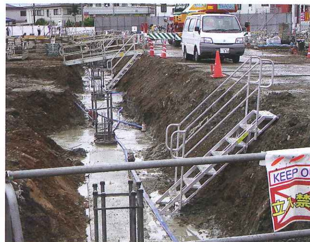
基礎工事の時の昇降設備
