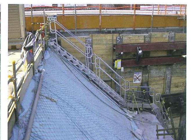
橋梁基礎部への昇降設備
