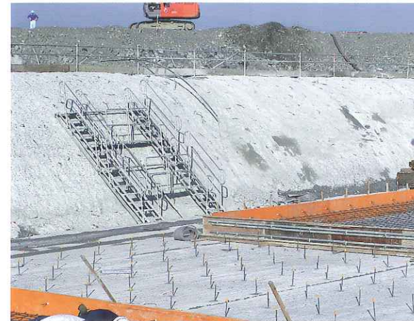
古い落差壁のはつり用 (作業足場設置例)
