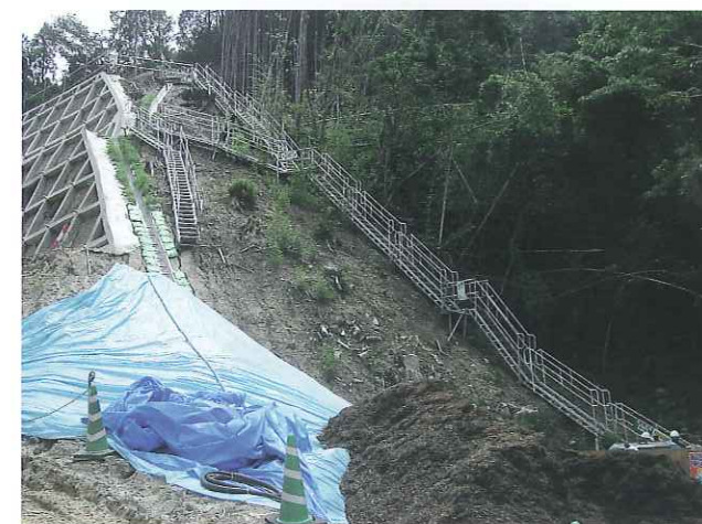
砂防流路工事 (昇降及び作業足場)
