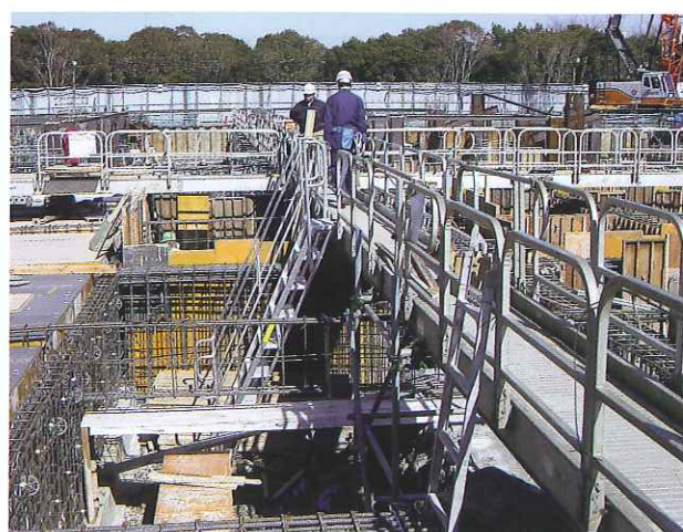
地中梁鉄筋を乗り越える為の使用
