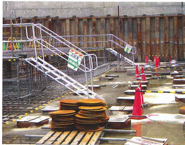
地足場より作業場への昇降設備
