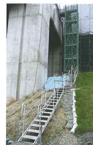
上部工工事の昇降用通路
