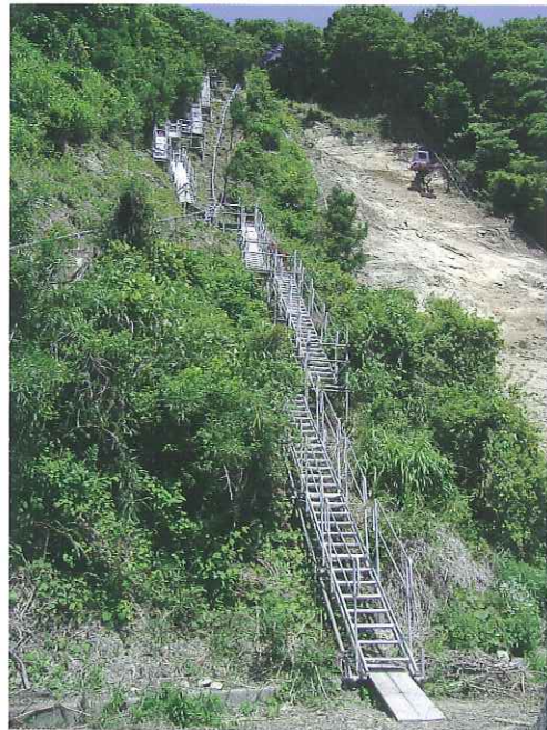
法面工事準備段階で使用
