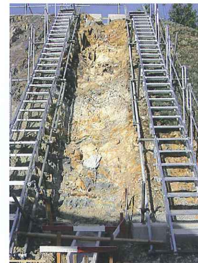
砂防流路工事 (昇降及び作業足場)
