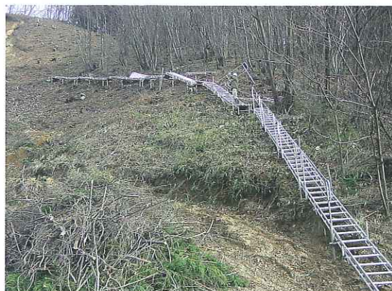
作業員の昇降用通路 (組立状況)
