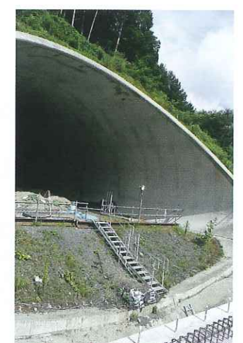
トンネル入口への昇降設備
