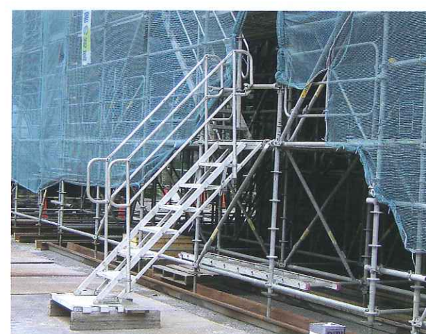
足場支保工への昇降用通路
