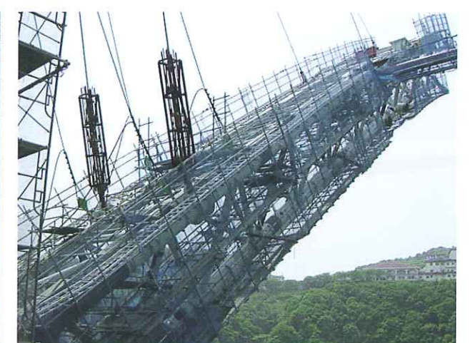
メタルアーチ橋での昇降設備(工事進捗により角度が変わる)
