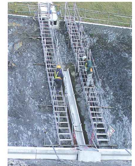
砂防流路工事 (昇降及び作業足場)
