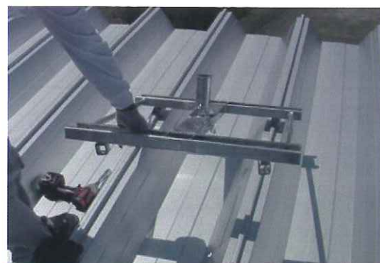
①支柱ベース仮置きする。その時に、ハゼ金具のナットをインパクトレンチで緩めておく。
