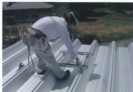
②設置箇所は、親綱システム用支柱の使用基準(表1及び図1)に従って計測して位置決める。
