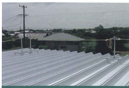
⑧親綱を取付け、緊張器を用いて、概ね水平になるように緊張して完成。
