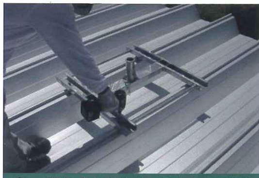
④ハゼ金具のナットをインパクトレンチで締め込み固定する。(ハゼ金具4ヶ所)
