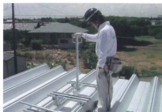
⑤支柱を支柱ベースの中央ソケット部に差し込む。
