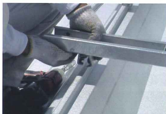
③ハゼ金具の口を広げて、ハゼ部に咬ませるようにセットする。(ハゼ金具4ヶ所)
