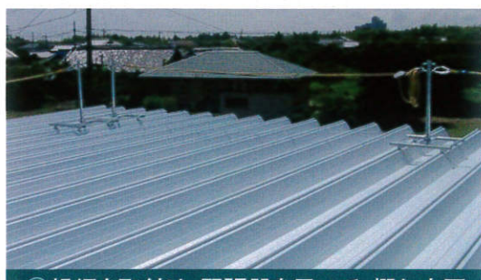
⑧親綱を取付け、緊張器を用いて、概ね水平になるように緊張して完成。
