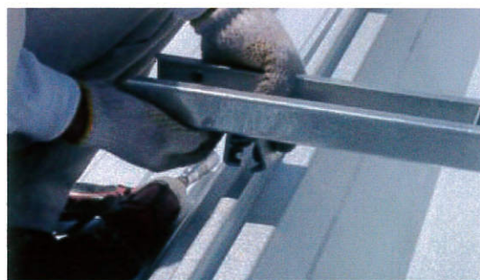
③ハゼ金具の口を広げて、ハゼ部に咬ませるようにセットする。(ハゼ金具4ヶ所)
