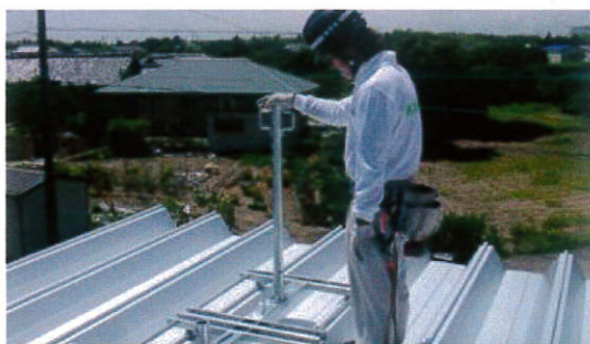
⑤支柱を支柱ベースの中央ソケット部に差し込む。
