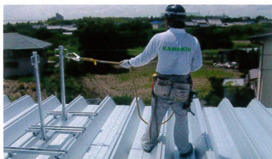
⑦親綱のフックを支柱の取付ピースに掛ける。
